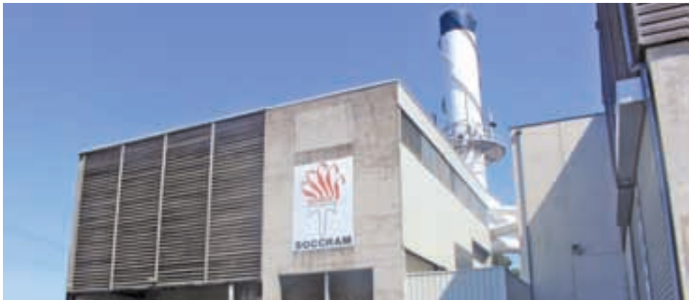
La chaufferie de Dole
