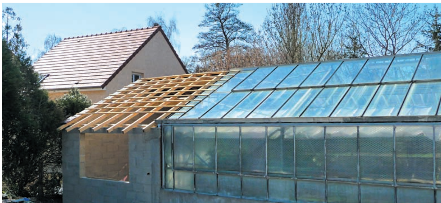
♦ Extension de la serre afin d'accueillir un système de chauffage au bois.
