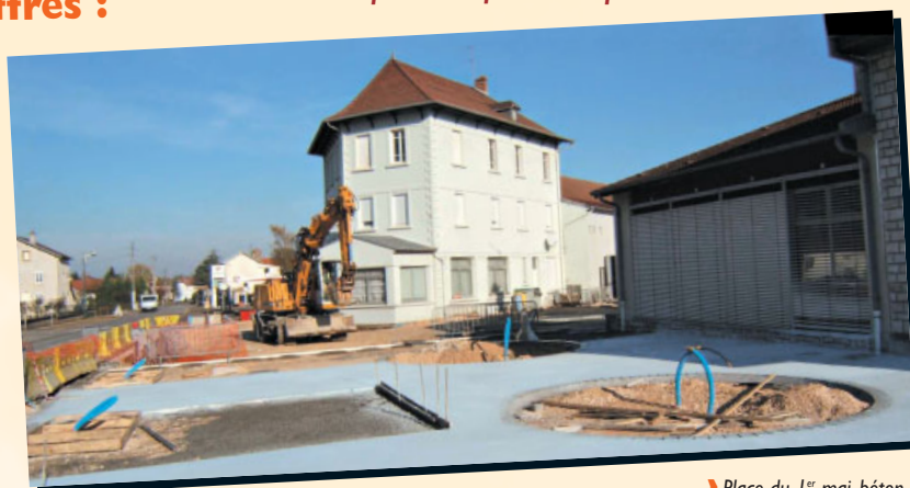
» Place du 1 er mai, béton désactivé en cours de réalisation.
