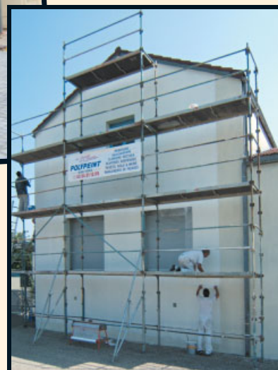
» Réfection des façades de l'école élémentaire.
