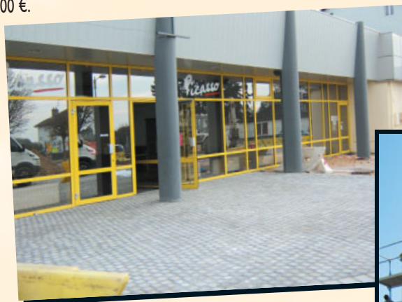
» Place du 1 er mai, pose des pavés granit.
